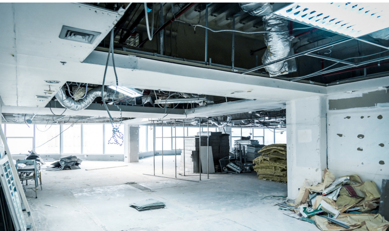
Alles draadloos, alles vanuit het plafond
